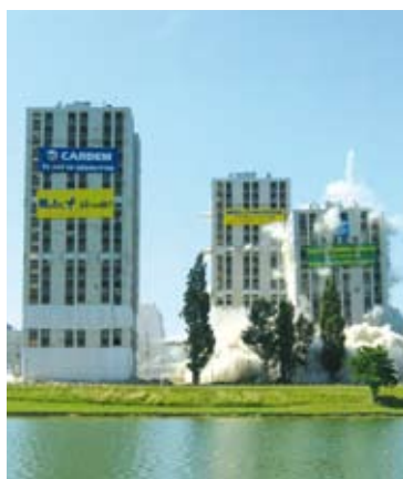
Démolition Tours DEGAS
