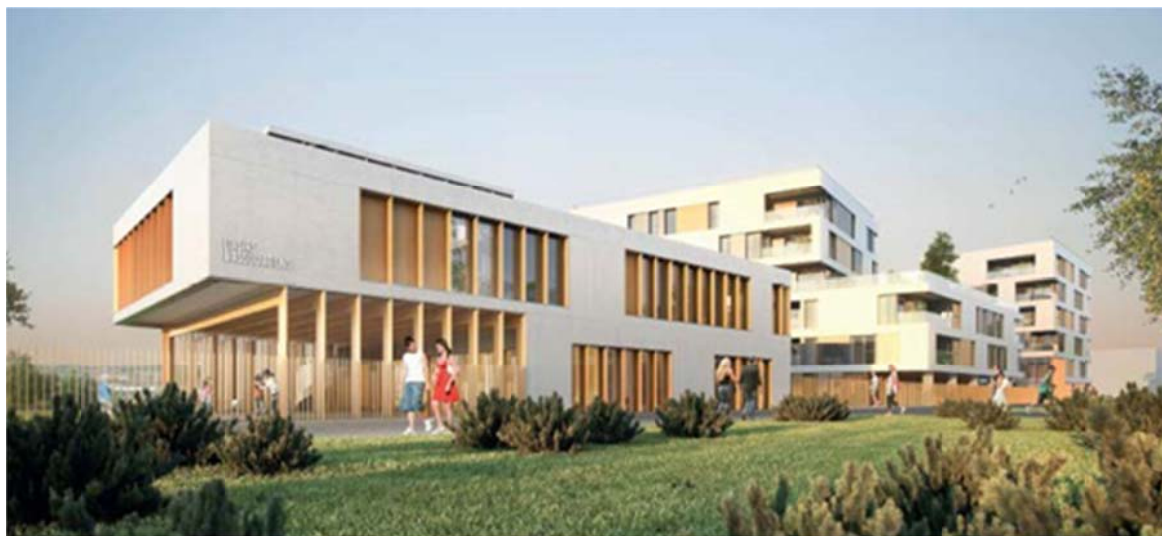
Centre de loisirs ICF, agence PPX
