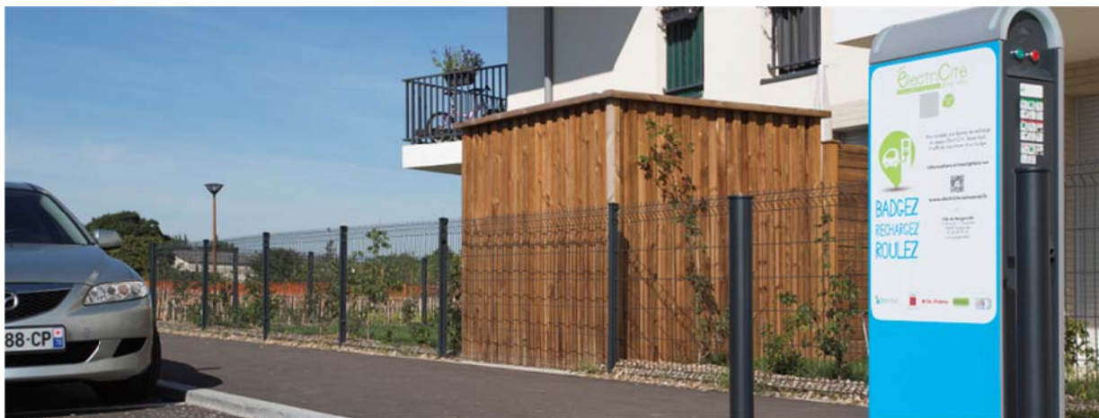
Une borne du réseau ÉlectriCité Seine Aval à Gargenville
