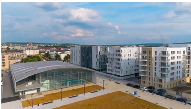
Aquasport, architecte : Marc Mimram
