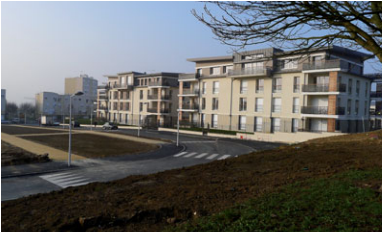
Chanteloup-les-Vignes > Aménagement quartier des Marottes
