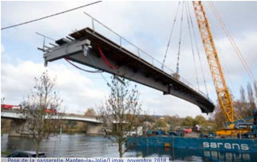
Pose de la passerelle Mantes-la-Jolie/Limay, novembre 2018
