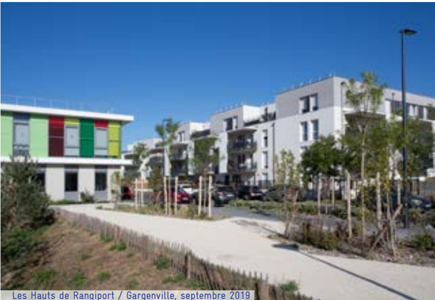
Les Hauts de Rangiport / Gargenville, septembre 2019
