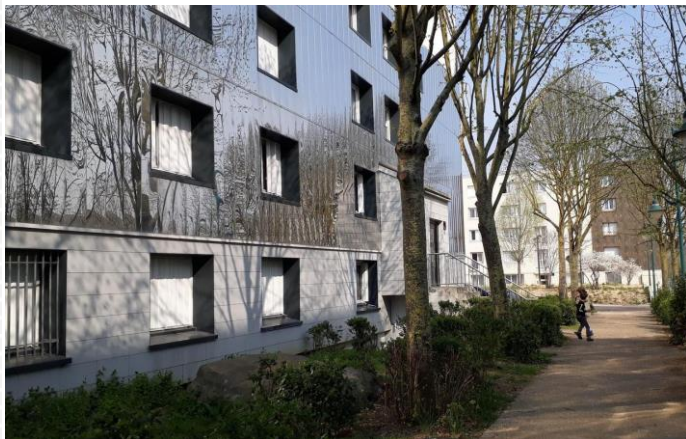
Des plaques de métal sur les façades LP/MEHDI GHERDANE.
