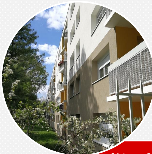
Bâtiment Pégoud, après travaux
