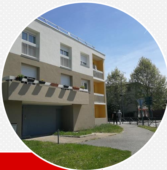
Bâtiment Sully, après travaux
