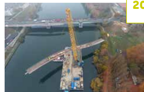
Pose des deux tronçons de la passerelle Mantes-la-Jolie/Limay. Conçu par l'agence Dietmar Feichtinger Architectes, cet ouvrage d'art dédié aux mobilités douces est inauguré en septembre 2019.
