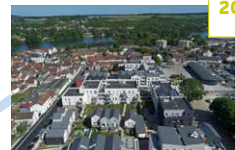
À Bonnières-sur-Seine, la première phase de la ZAC Cœur de Ville est en voie d'achèvement. Un centre-ville redessiné, pleinement approprié par les habitants et les usagers des communes alentour.
