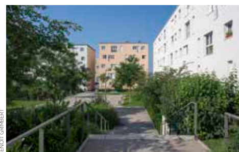
L'aménagement de la rue Cours Toujours, inaugurée en juin, est la dernière opération en mandat dans le cadre des actions du programme de renouvellement urbain (PRU) du quartier la Noë à Chanteloup-les-Vignes.
