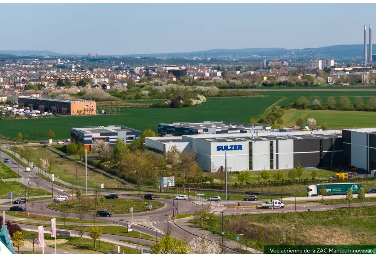
Vue aérienne de la ZAC Mantes Innovaparc
