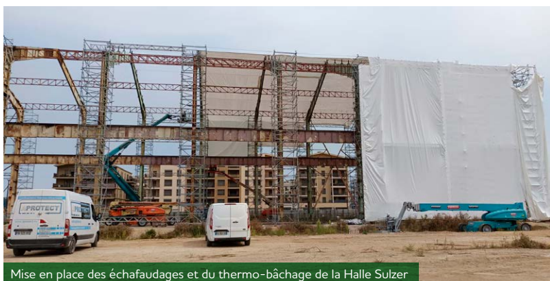
Mise en place des échafaudages et du thermo-bâchage de la Halle Sulzer
