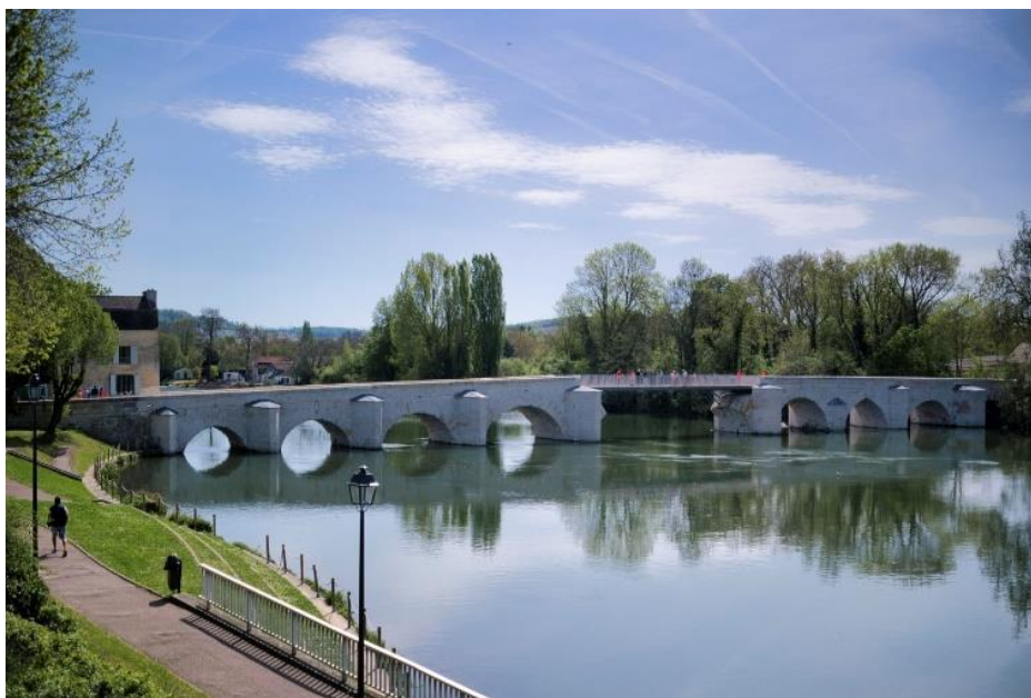
Le Vieux Pont, datant du XI e siècle, supporte désormais une passerelle de 120 mètres reliant Mantes-la-Jolie à Limay. ©GPS&O
